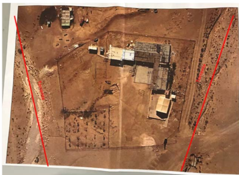
Foto 1 - Visione dall'alto della scuola di Dkeika (in rosso i due torrenti)
