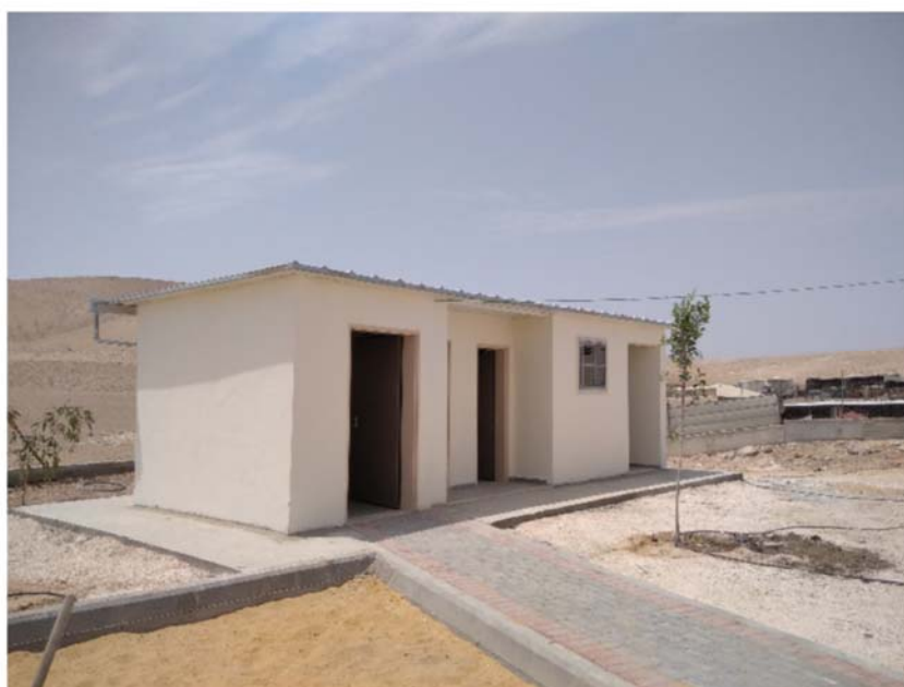
Foto 6 - Facciata della scuola ristrutturata
