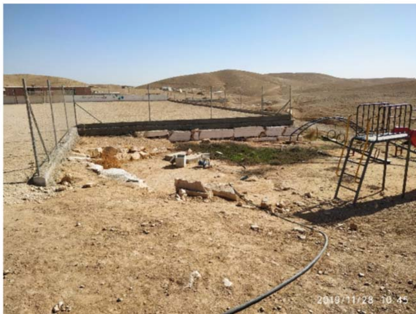
Foto 7 - Area giochi prima della ristrutturazione
